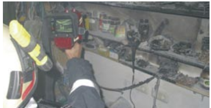
Kontrolle mit der Wärmebildkamera.
